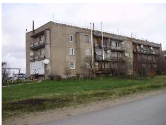
33.att. Daudzdzīvokļu ēkas Skujenē ar dažādiem skursteņu nedrošiem inženiertehniskiem risinājumiem
