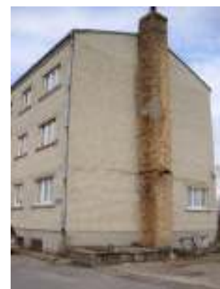
33.att. Daudzdzīvokļu ēkas Skujenē ar dažādiem skursteņu nedrošiem inženiertehniskiem risinājumiem
