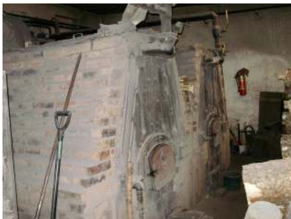
11.att. Čuguna sekciju katli un malkas šķūnis
